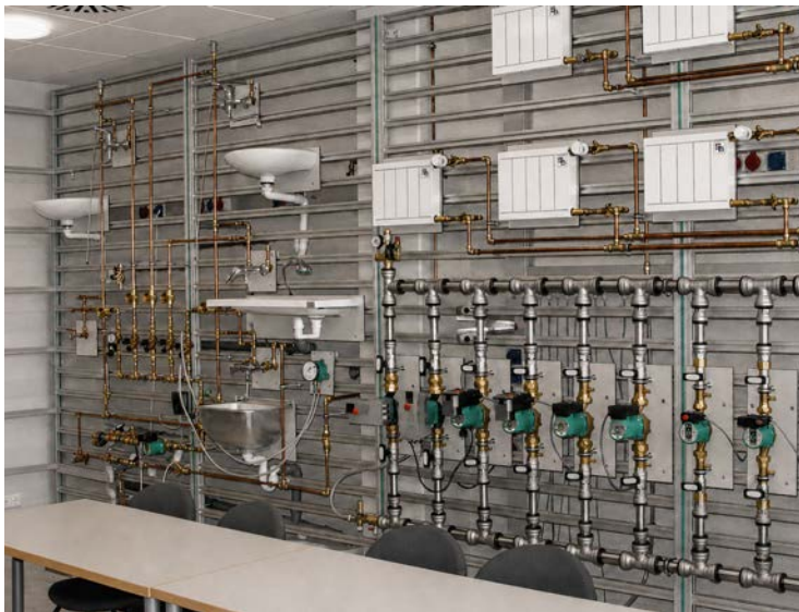
Schulungsraum mit Wandarbeitsplätzen
